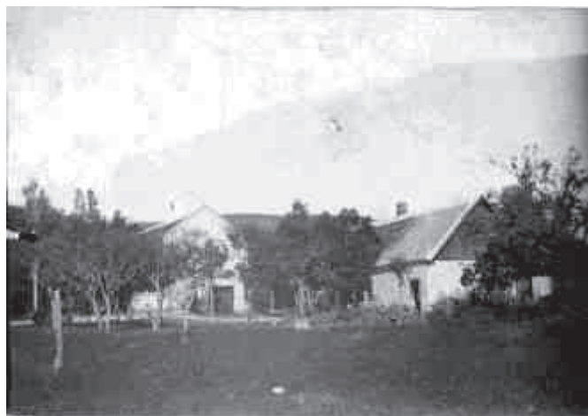
A gazdasági épületek
